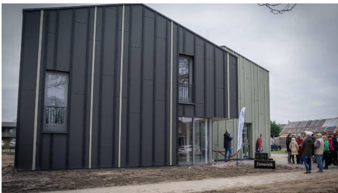
Woonvoorziening Zomereik aan de Bosstraat. © Foto RedMouse
